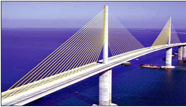
<그림-4> Sunshine Skyway Bridge
