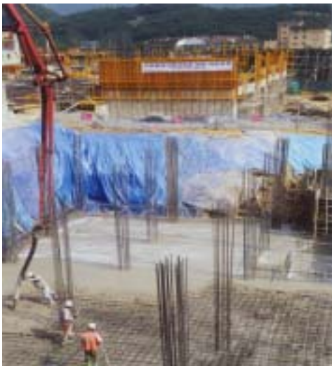
<사진-1> 콘크리트 타설전경
